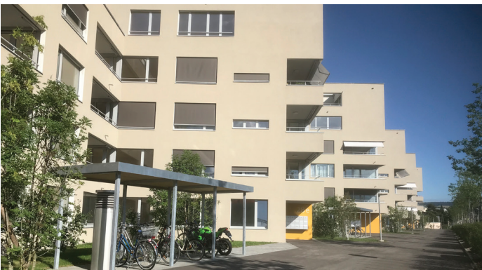
La «nouvelle construction massive» selon l'étude de la HSLU: bâtiment Minergie construit en 2017, équipé d'une protection solaire automatisée ainsi que d'une ventilation mécanique. Photo: B. Vogel
