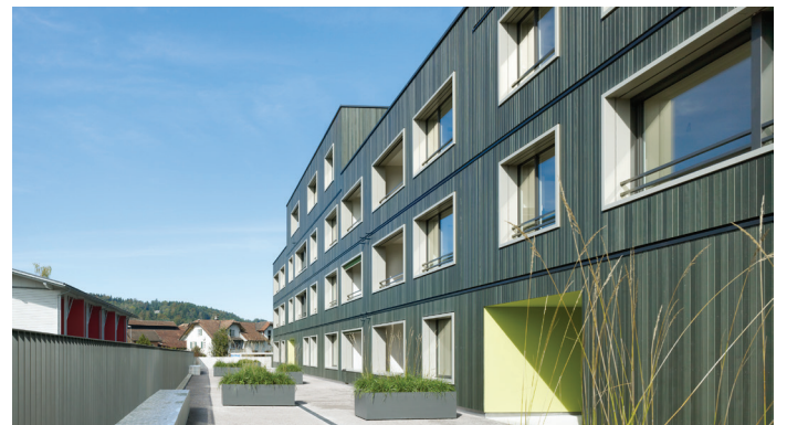
La «nouvelle construction hybride» selon l'étude de la HSLU: Le bâtiment construit en 2014 se compose essentiellement de bois. Photo: Renggli AG, Sursee
