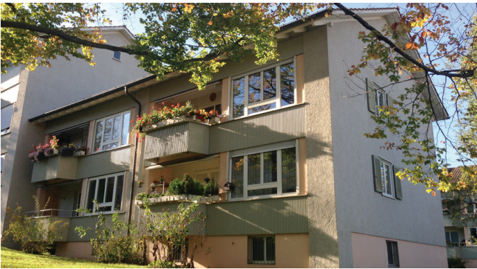
Le «bâtiment ancien standard» selon l'étude de la HSLU: le bâtiment a été construit en 1954 avec une façade en brique et en béton armé. Photo: CCTP, HSLU
