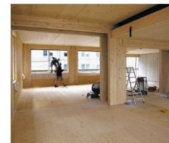
Abbildung 119: Gebäudetyp 10 Leichtbau – Stützträgersystem Holz, Aussenwände in Holzrahmenbau.
