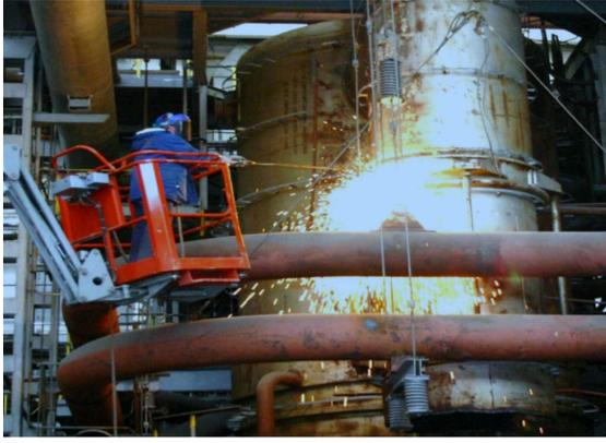
*Fig. 2 : Démontage d'un gros composant (Photo : Marlies Philipp, AKW Greifswald)*
